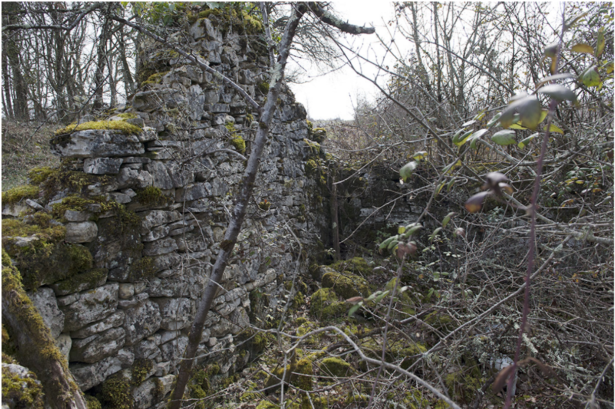
Fig. 27 - Vue de l'intérieur, mur pignon.
