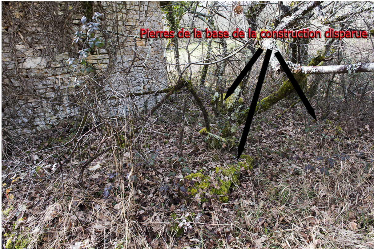
Fig. 5 - Cabane de Nadalie, emplacement de la construction qui existait sur le cadastre napoléonien.
