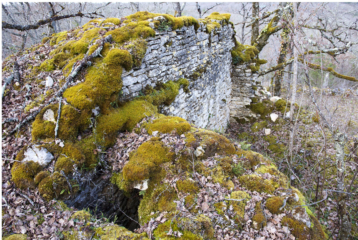
Fig. 16 - Cabane N°1515 : au premier plan couverture effondré de la cellule bâtie à l'angle du retour d'un mur gouttereau et du mur pignon.
