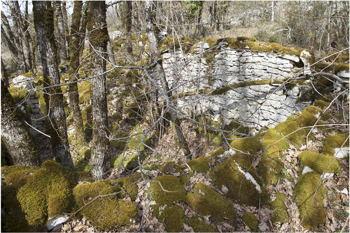
Fig. 36 - Ruine de la construction N°921.
