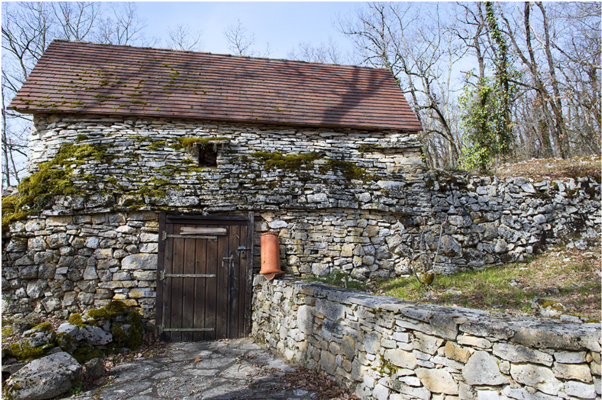
Fig. 35 - Vue des aménagements réalisés à partir de l'ancienne construction.
