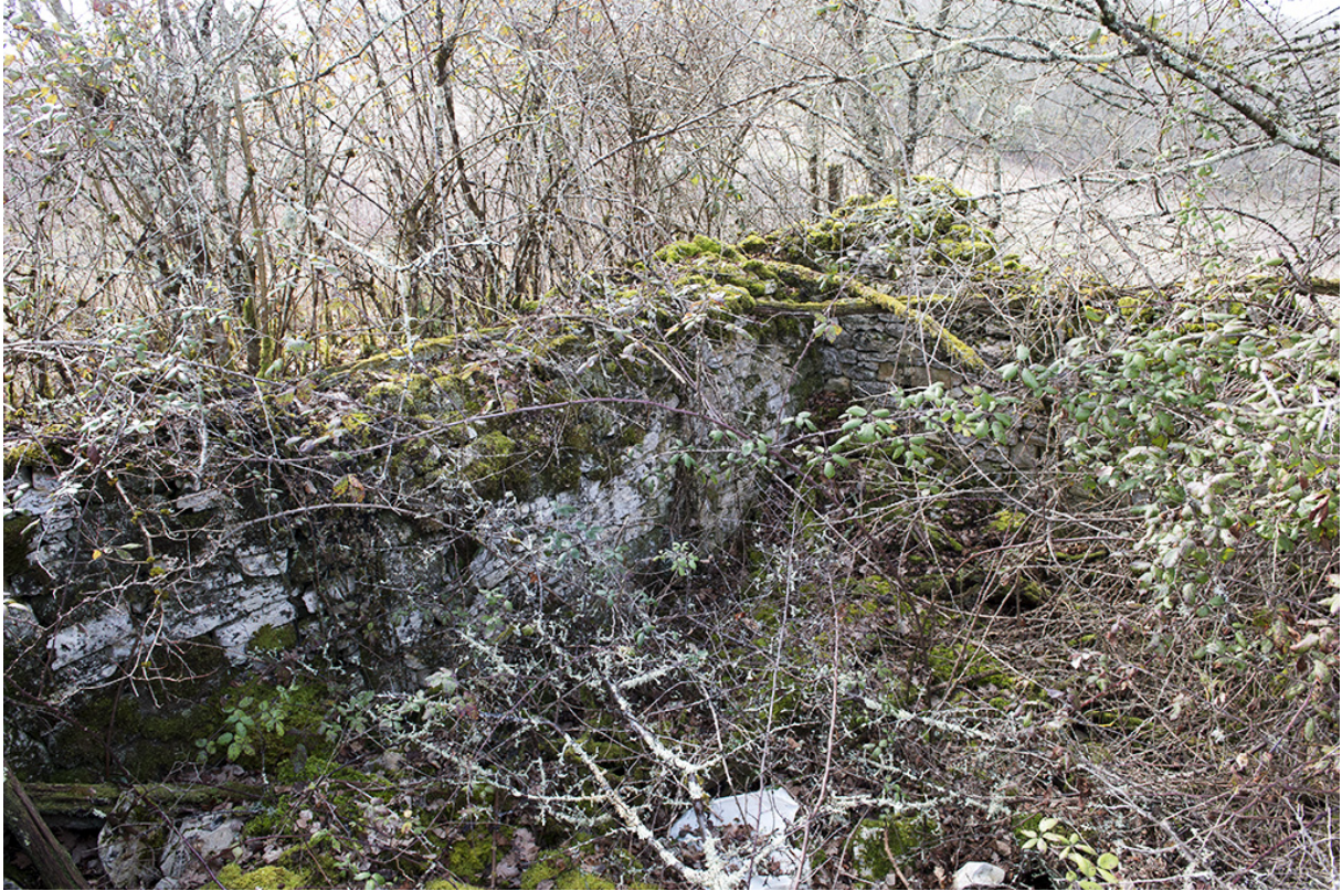
Fig. 26 - Intérieur de la cabane : les murs sont encore visibles sur le pourtour de la construction.
