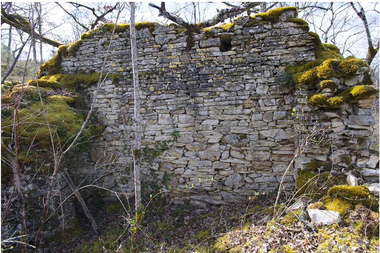
Fig. 18 - Mur pignon avec une niche en hauteur et les retours des deux murs.
