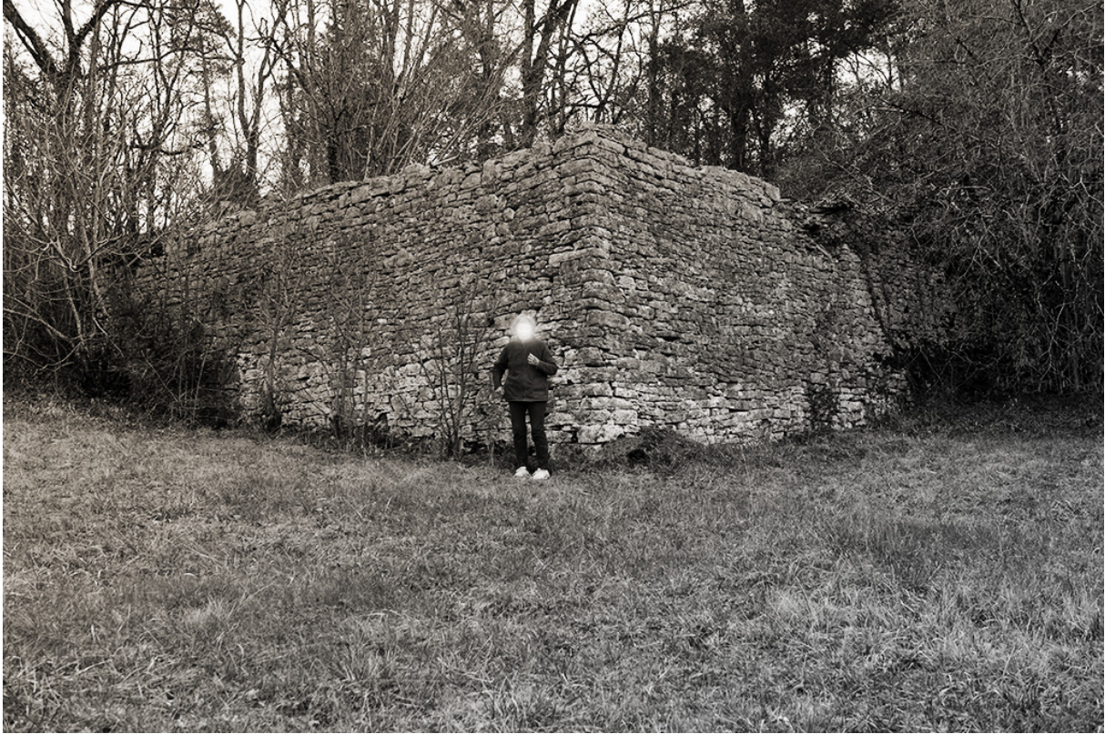
Fig. 55 - Tas d'épierrement bien bâti sur la commune de Daglan, le volume approximatif de ce tas est d'environ 400m 3 .
