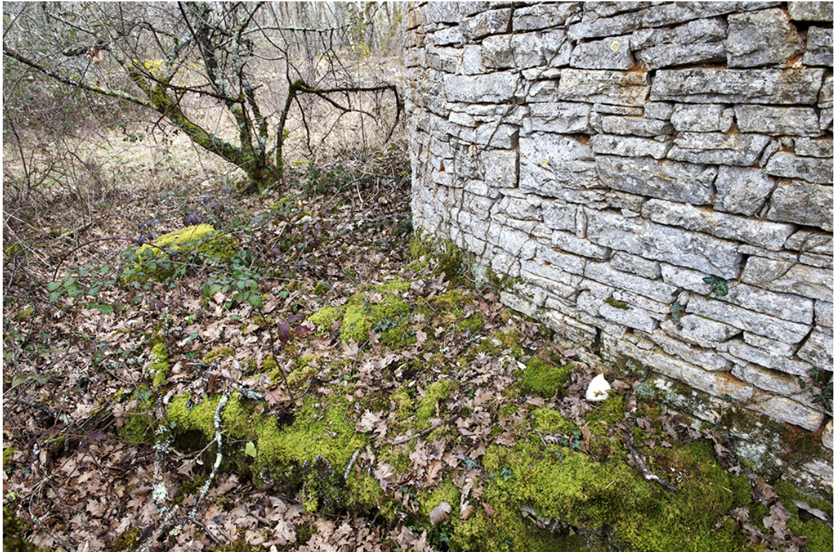
Fig. 6 - Vue de derrière, sous les mousses, pierres de l'ancienne construction.
