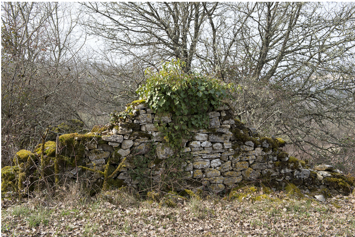
Fig. 25 - Reste du mur pignon au niveau de la route actuelle.
