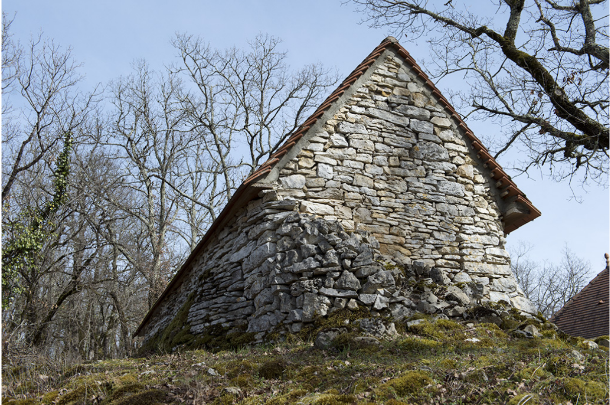
Fig. 34 - Vue du mur pignon en contre-plongée à partir de la muraille en limite de parcelle.
