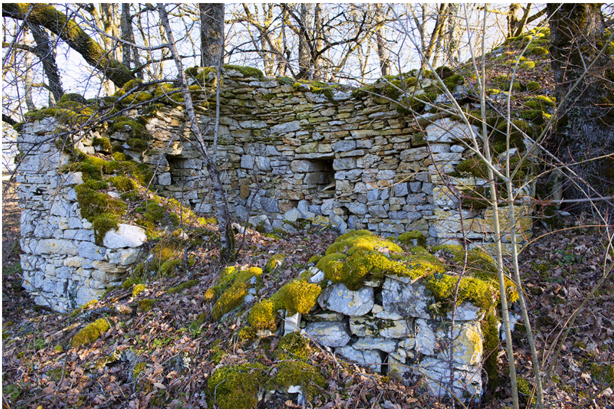
Fig. 44 - Cabane ruinée à l'emplacement de la construction mentionnée sur le cadastre Napoléonien.
