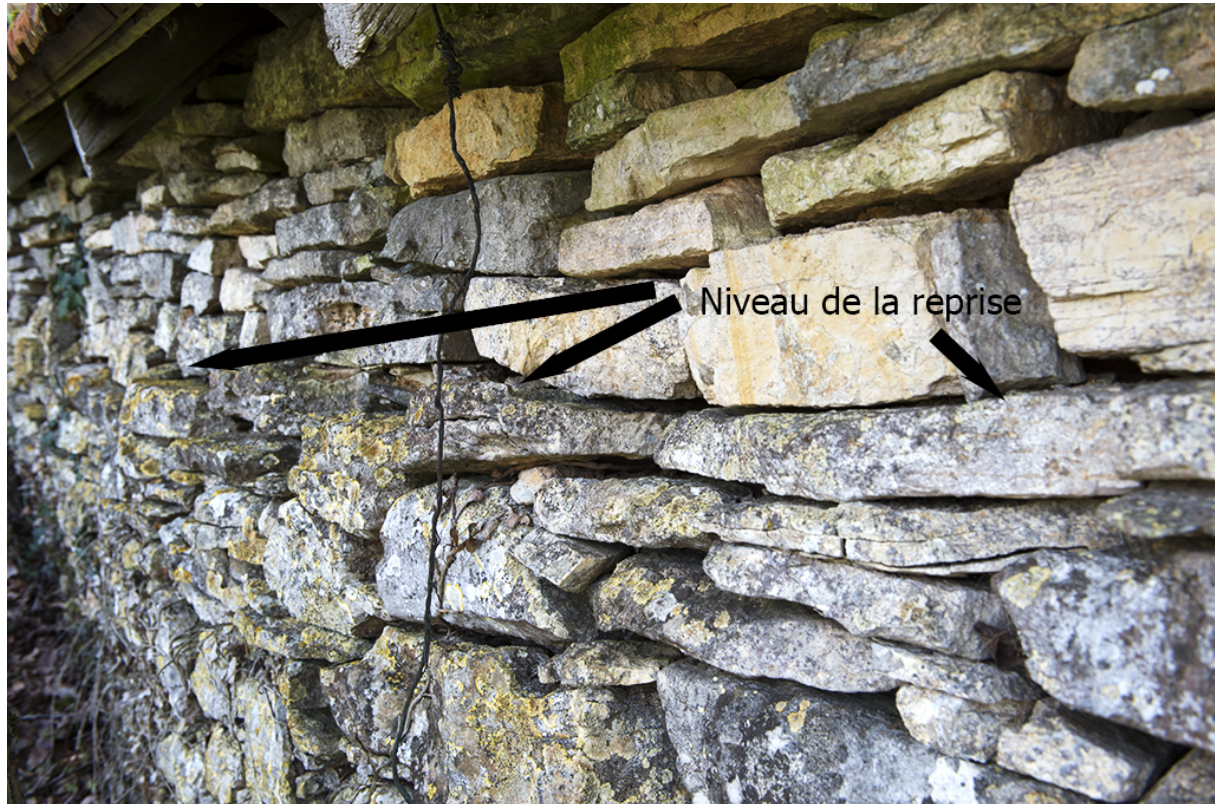
Fig. 31 - On voit très bien l'endroit de la reprise pour la nouvelle construction.
