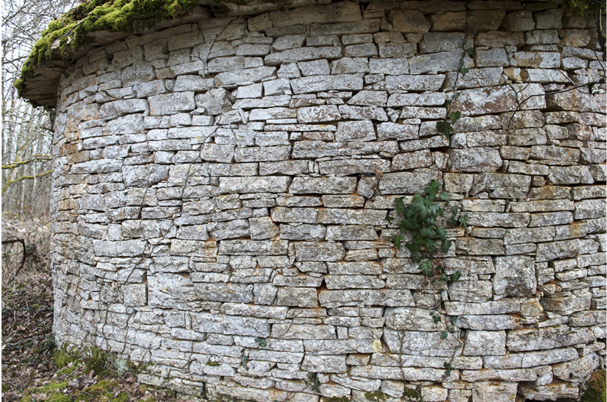
Fig. 7 - Cabane de Nadalie : le parement ne présente aucune modification.
