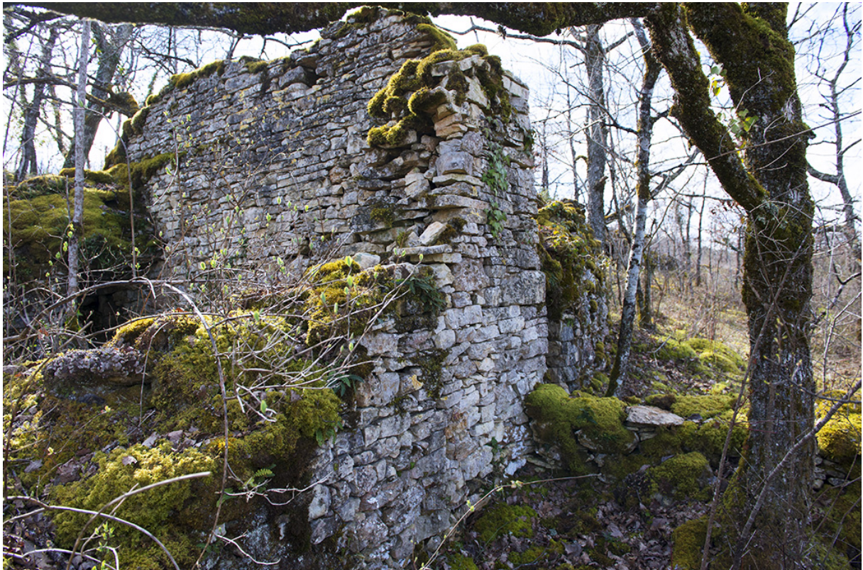
Fig. 20 - Vue de la partie existante du mur gouttereau en retour du pignon côté enclos. La hauteur du mur donne une idée des volumes de la construction, relativement haute
