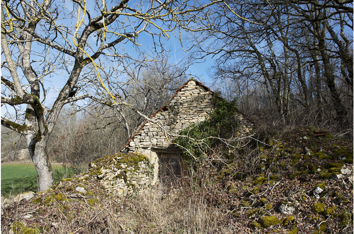
Fig. 30 - Cabane de Fordon, nouvelle construction sur les bases des ruines de l'ancienne cabane.
