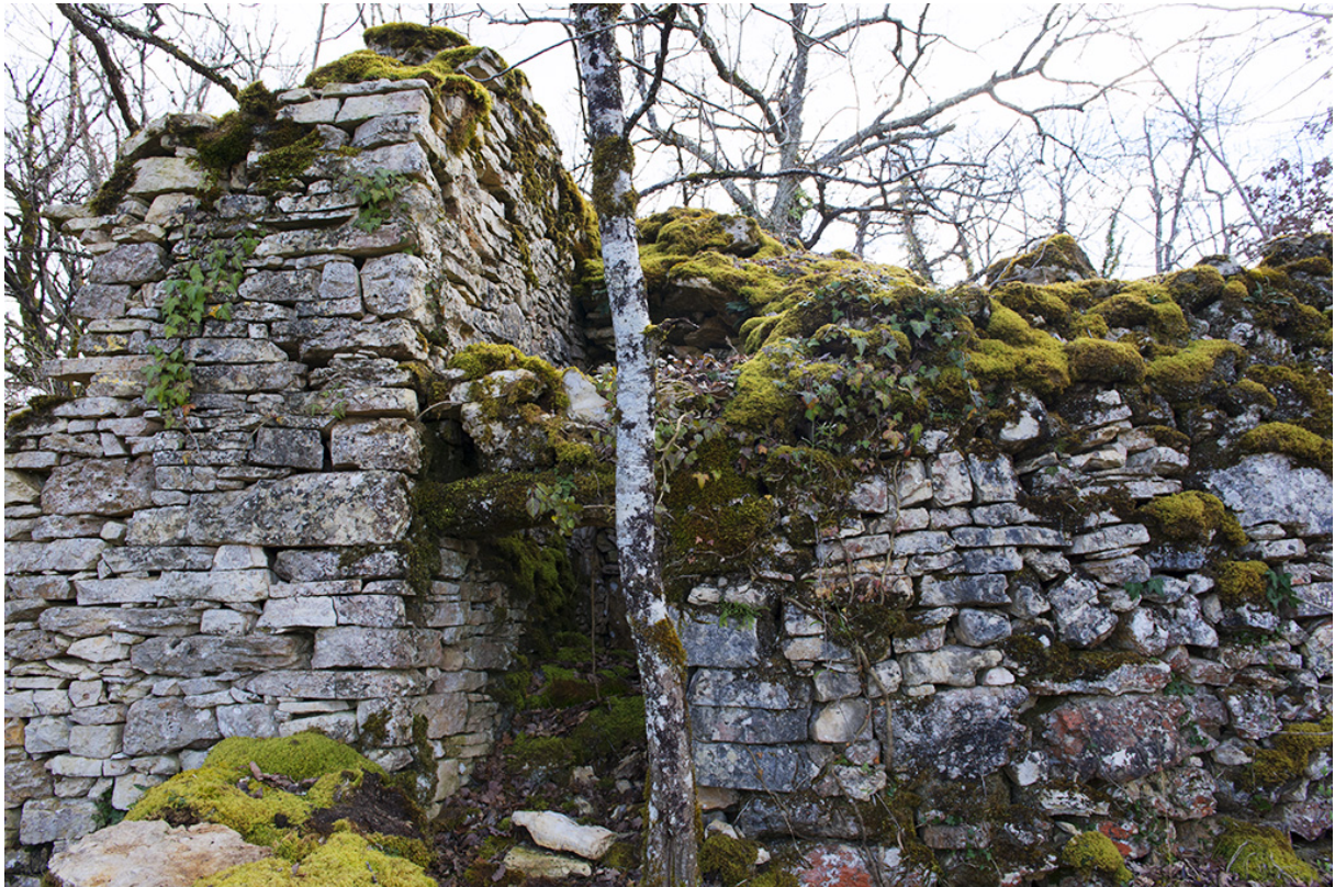
Fig. 19 - Vue sur la cabane bâtie contre le mur pignon sur la parcelle N°1516, construction postérieure à l'établissement de la feuille de l'ancien cadastre.
